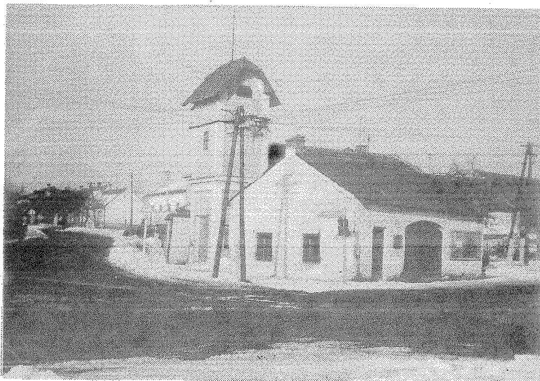
Obr. 3. Budova staré požární zbrojnice a zděná trafostanice na křižovatce
