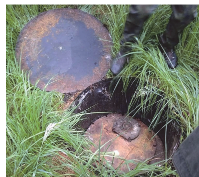
Obr. 63 Krycí víko podzemní vodní nádrže v lesním porostu
