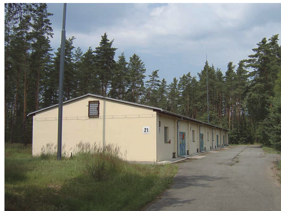
Obr. 118 Muniční skladiště s požární prolukou
