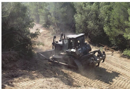
Obr. 128 Vytváření protipožárních pásů/proluk odstraněním vegetace kolem obce, VVN, v lesním porostu apod.
